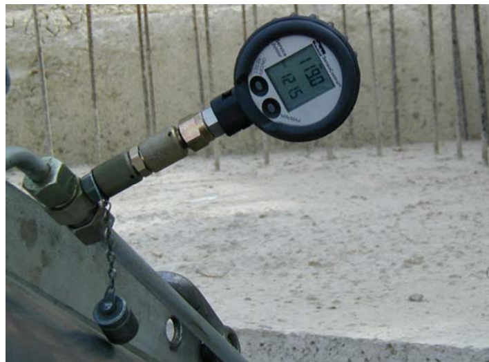
Figura 44: Manómetro de lectura digital instalado en circuito hidráulico junto al gato (U&A).
