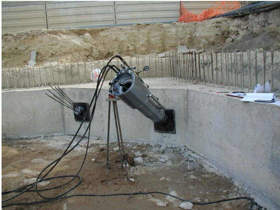
Figura 24: Detalle de gato de tesado (U&A).
