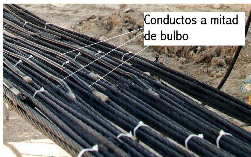
Figura 18: Conductos para inyección repetitiva IR.
