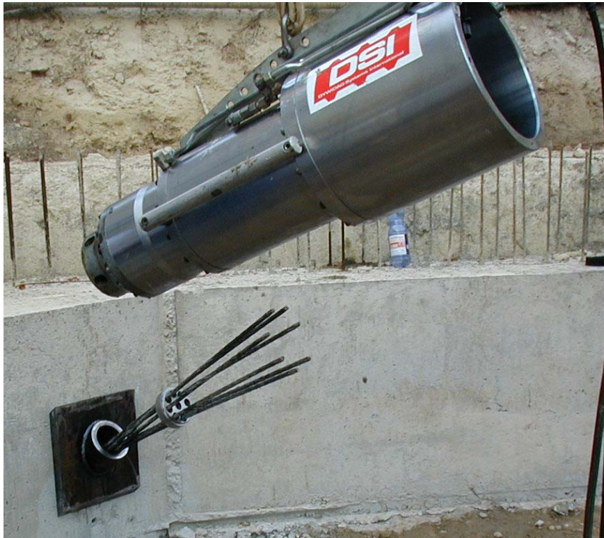
Figura 13: Fotografía de un anclaje de 7 cables en la coronación de una pantalla. Se observa la placa de reparto mecanizada para conseguir la inclinación deseada, y el portacañas. En la parte superior, un gato hidráulico para el tesado (U&A).
