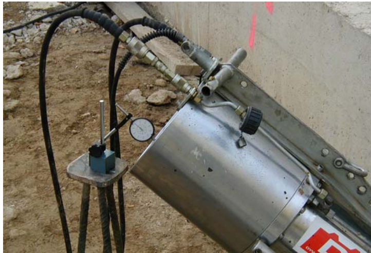
Figura 43: Montaje de gato hidráulico con pie de rey para medida de alargamientos (U&A).
