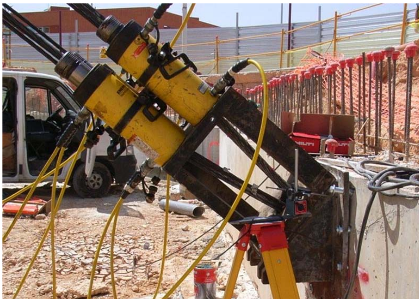
Figura 27: Montaje para tesado de un anclaje de bulbo múltiple. Cada uno de los gatos tesa un tirante (U&A).
