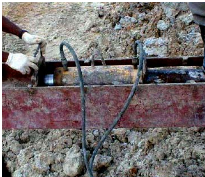
Figura 17: Trabajos de ejecución de anclajes tipo “jack-in”. (Tomada de www.plaxis.nl )
